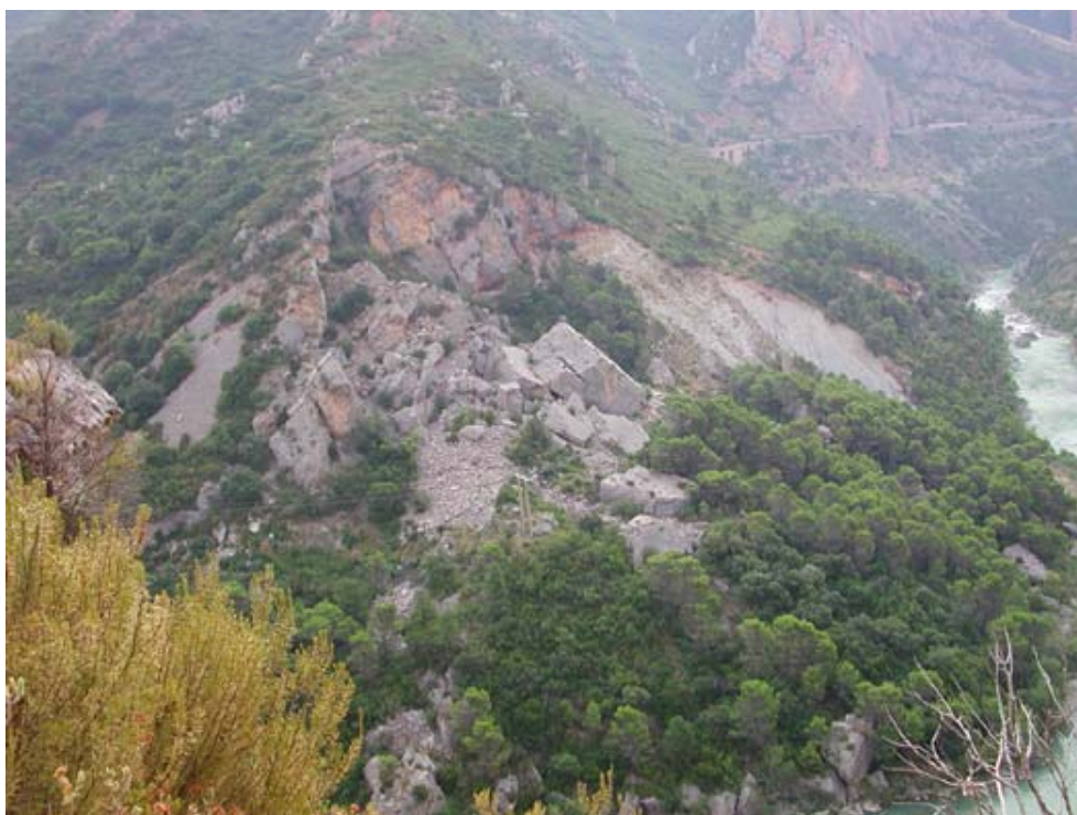
Foto 5.30.- Desprendimiento de bloques de caliza de Guara, junto al kilómetro 41,2 de la carretera A-132.
