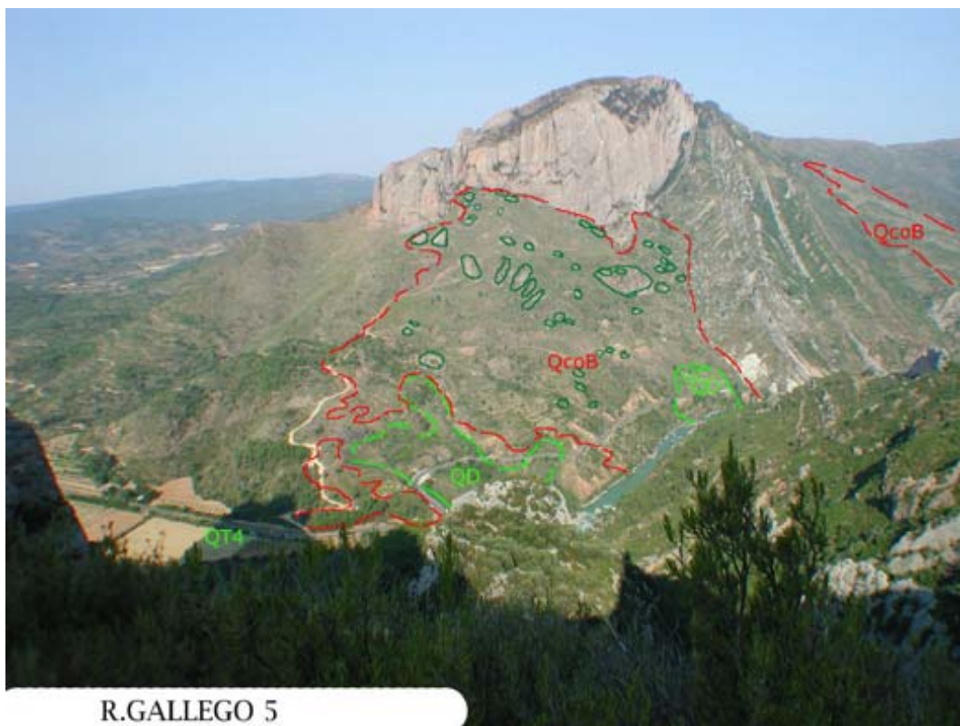
Foto 5.25.- Aspecto general de la ladera de la Raya des del norte del mallo Fire. Se ha marcado el límite aproximado (en rojo) del depósito coluvial QcoB (18) con grandes bloques, indicando los mayores bloques con trazo verde. En verde claro se delimitan los deslizamientos recientes ( QD = 27 ).
